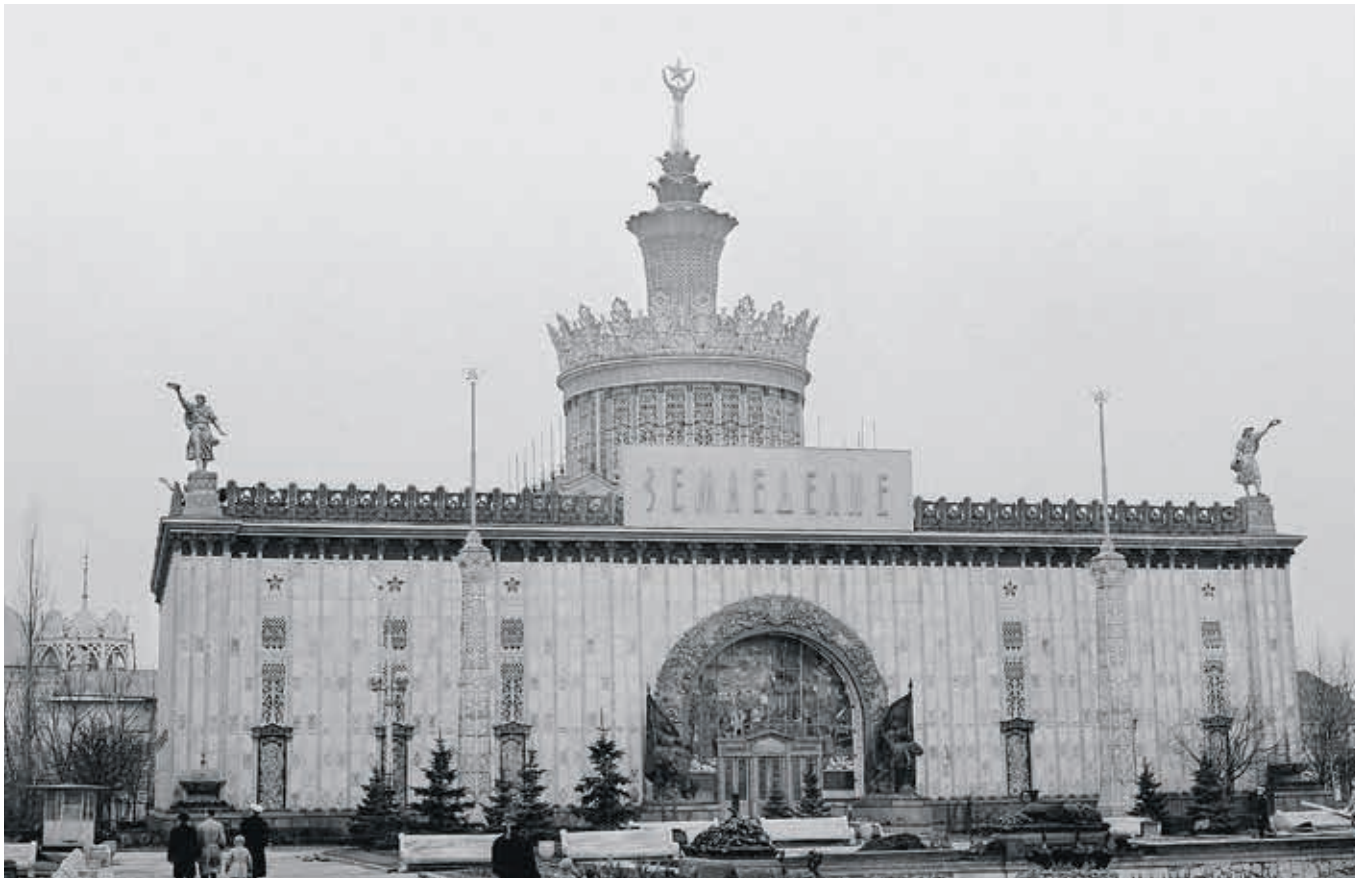
Общий вид павильона «Земледелие»
