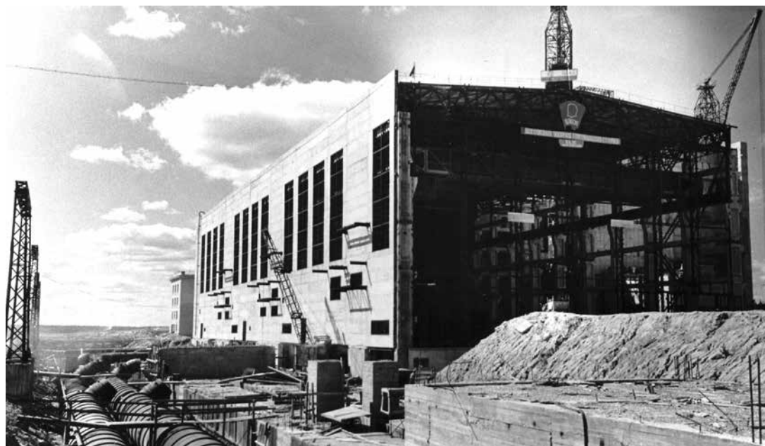
Возведение машинного зала 1-й очереди Белоярской АЭС
