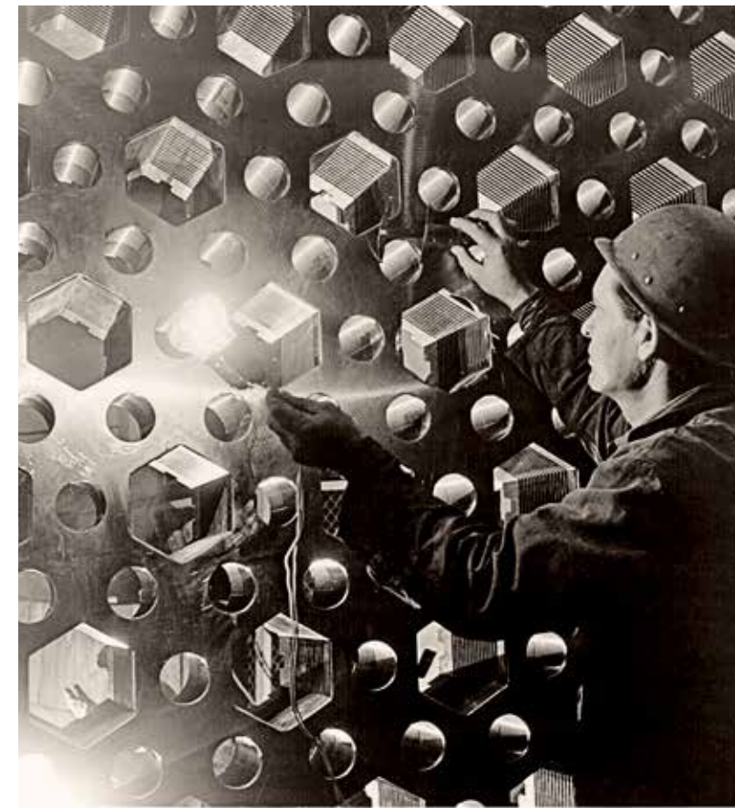
Монтаж реактора ВВЭР-440 НВАЭС
