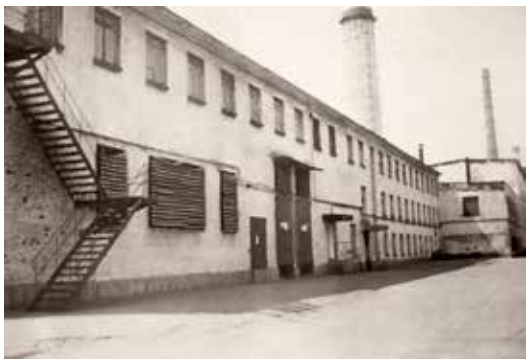
Главный корпус Завода «2 А»
