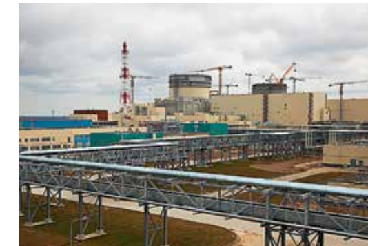
Промплощадка Белорусской АЭС
