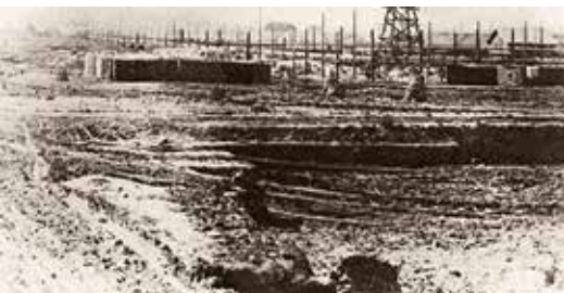
Строительная площадка Завода «А» в районе Карачаровского поля
