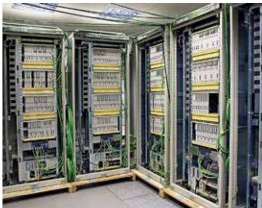
ВНИИА. Система автоматики для АЭС ТПТС-Е
