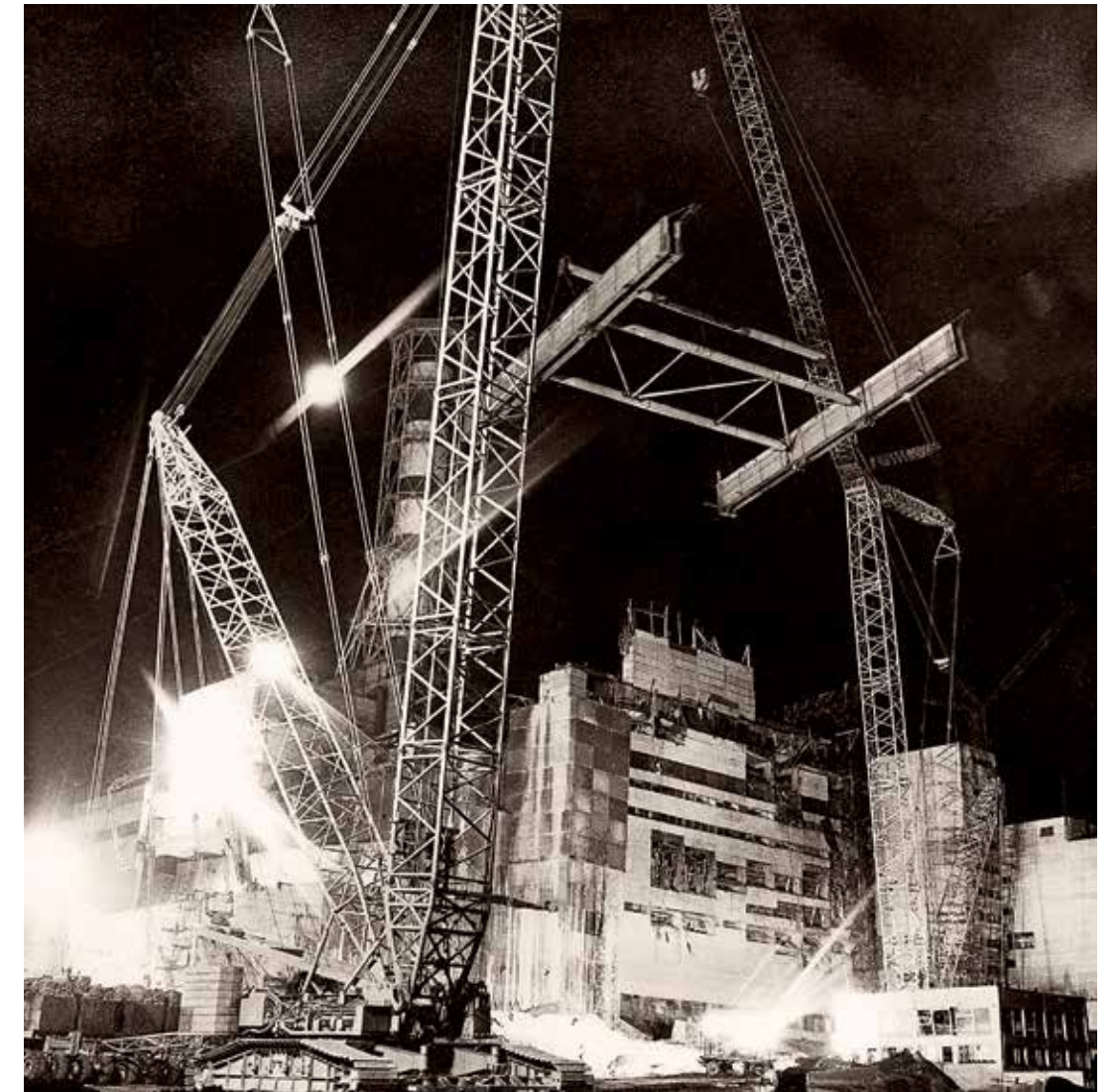
Работы по сооружению саркофага над 4-м энергоблоком шли днём и ночью
