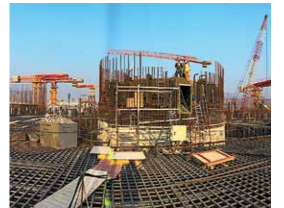
АЭС «Руппур». Монтаж ловушки расплава
