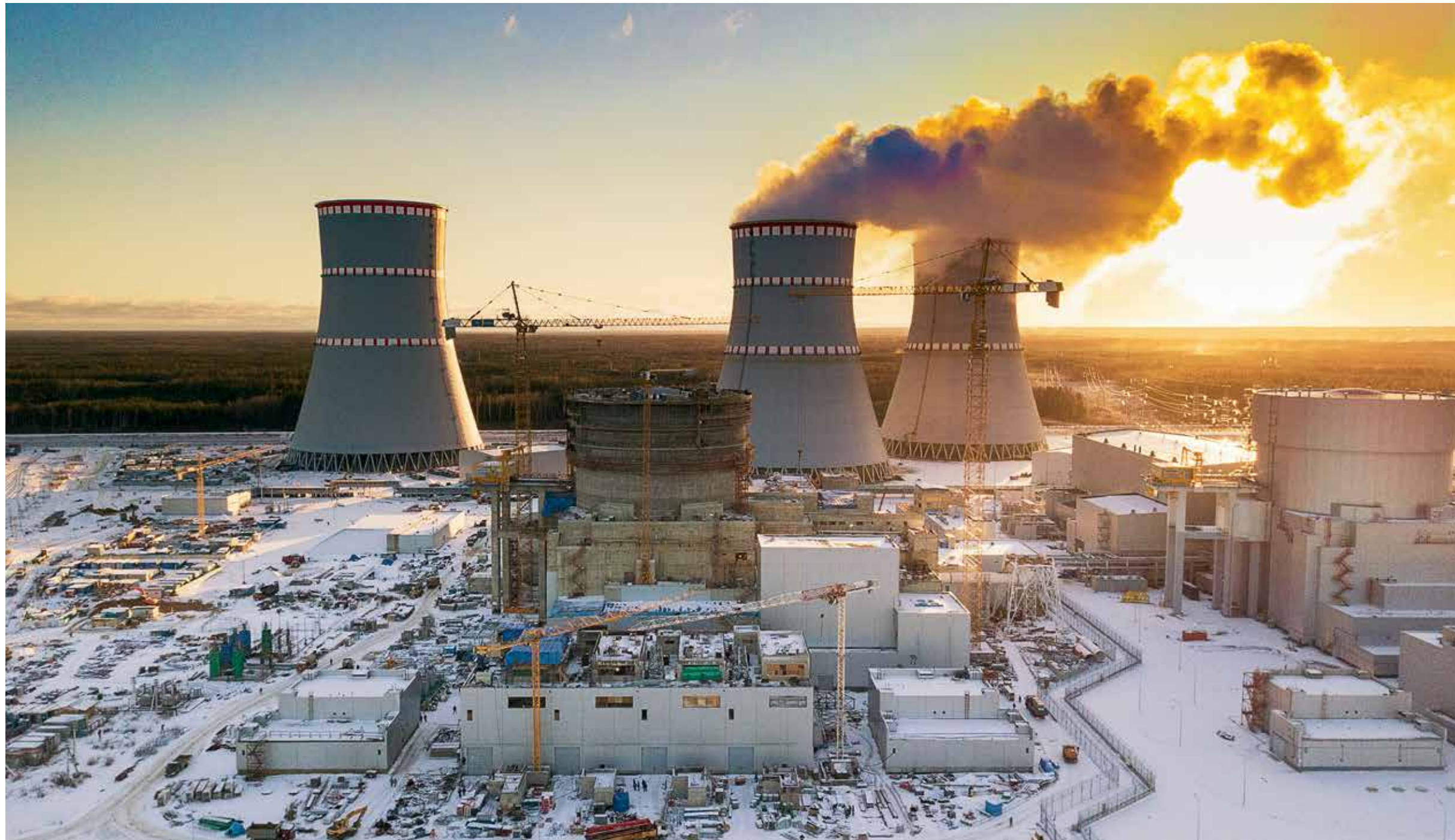
Строящаяся Ленинградская АЭС-2 (г. Сосновый Бор)
