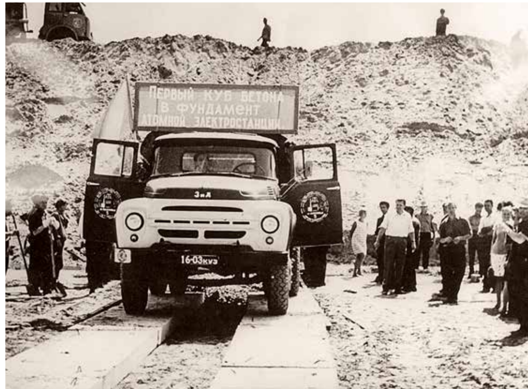
Первый кубометр бетона Курской АЭС
